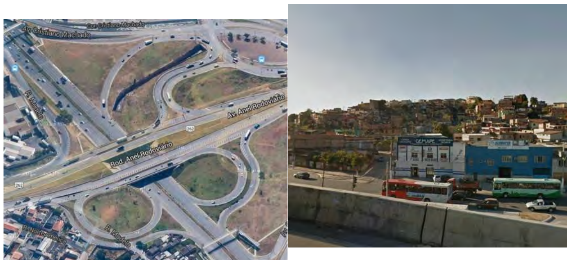
Trevo Anel Rodoviário/ Av. Cristiano Machado, Primeiro de Maio, Belo Horizonte. ZEIS Vila Primeiro de Maio, Belo Horizonte.
