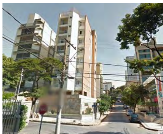
Tipologia residencial multifamiliar de classe média no bairro Coração Eucarístico, Belo Horizonte.
