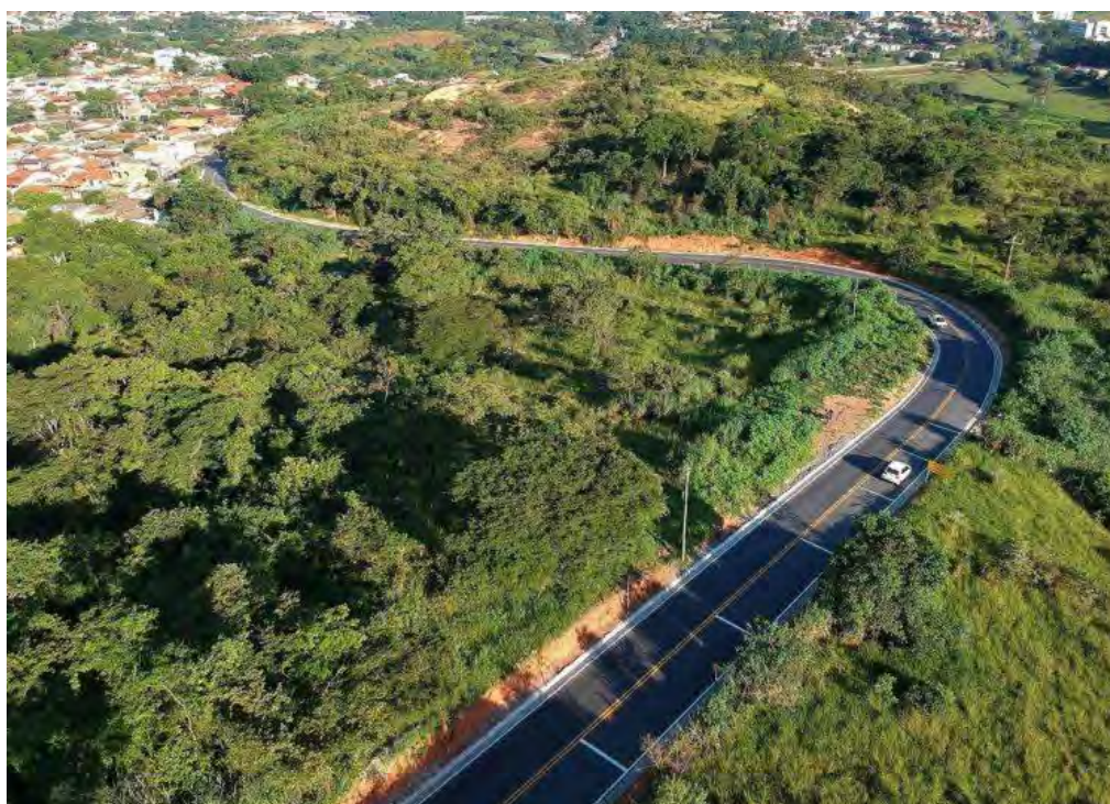
Imagem 77 - Foto da estrada do Alto das Maravilhas, com a pavimentação recentemente executada.
