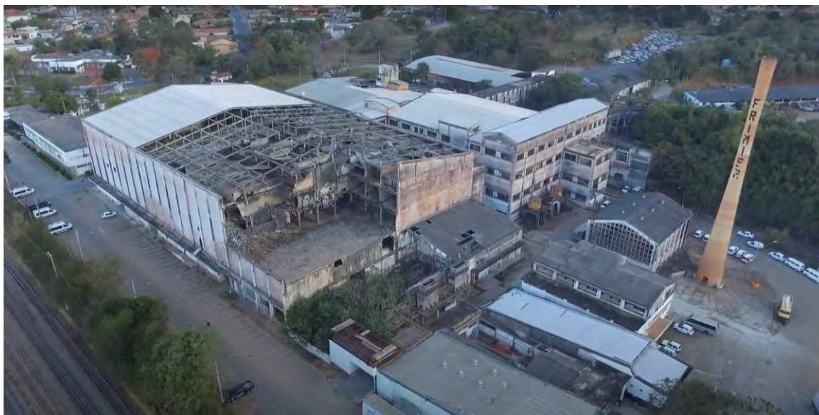
Imagem 17 - Vista da antiga FRIMISA, parte arruinada por um incêndio e outra utilizada atualmente pela Prefeitura Municipal com instalações da administração pública. Foto: Thiago Augusto Drones (2020)
