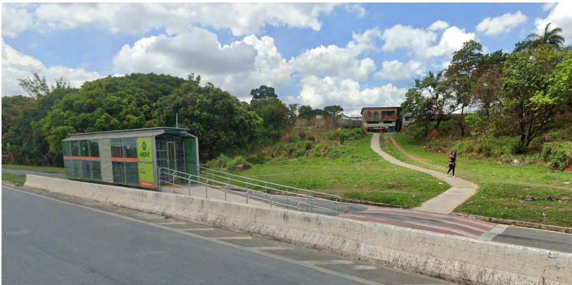
Imagem 79 - Estação do Move na Linha Verde (Rodovia MG-010) onde é possível observar um acesso construído desde a rodovia até a Avenida Senhor do Bonfim.
